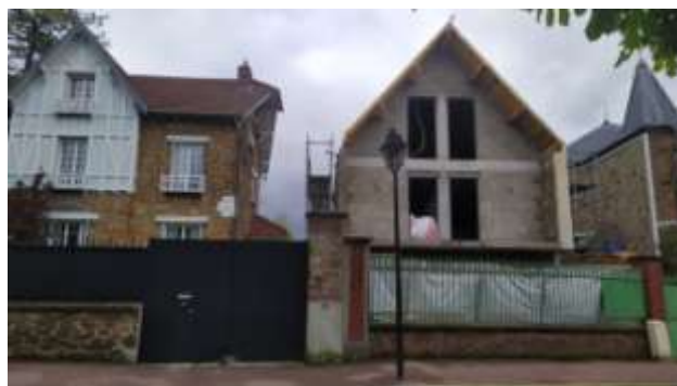
La construction bien plus imposante et pas en retrait
